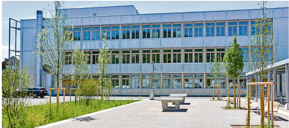
Die neue Kantonsschule Wattwil: Von aussen ist der Holzbau mit Wellblech verkleidet, welches die Sonne reflektiert.
