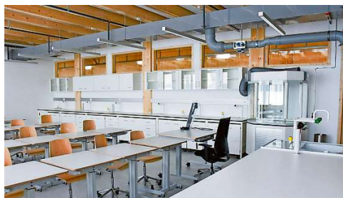
Naturwissenschaftliches Unterrichtszimmer: Experimente können gleich im Klassenzimmer durchgeführt werden.
