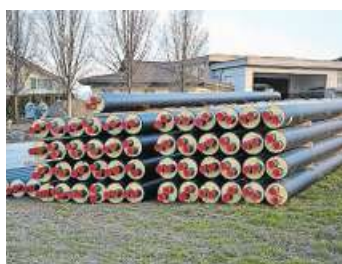
Fernwärmerohre liegen schon bereit. Bild: Beat Lanzendorfer
