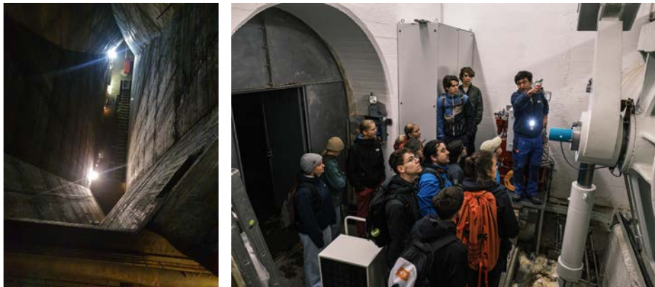
Abb. 9: Die Exkursion 2024 führte uns in den Albiga-Staudamm, wo nebst der Staumauer selber (links) die Mess- und Überwachungstechnik das grosse Thema war (rechts).
